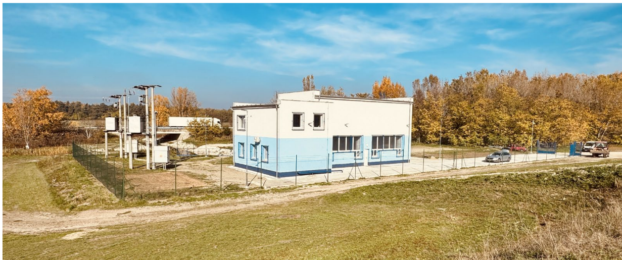
Čenkov - rekonštrukcia čerpacej stanice
