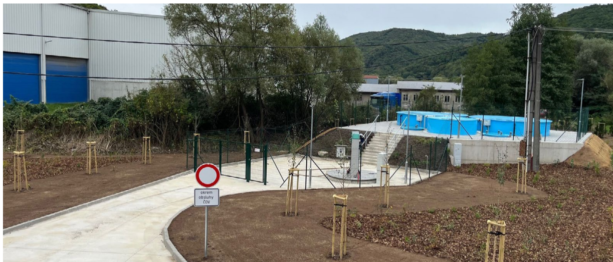
Prenčov - rozšírenie kanalizácie a ČOV
