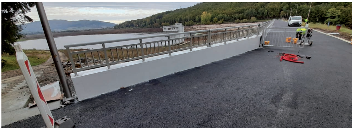
VS Ružiná, oprava vodnej stavby
