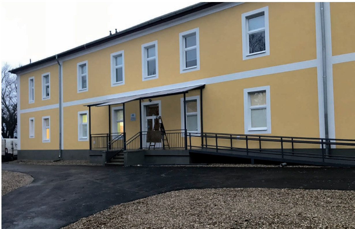
PJK Číž, rekonštrukcia LD Milan
