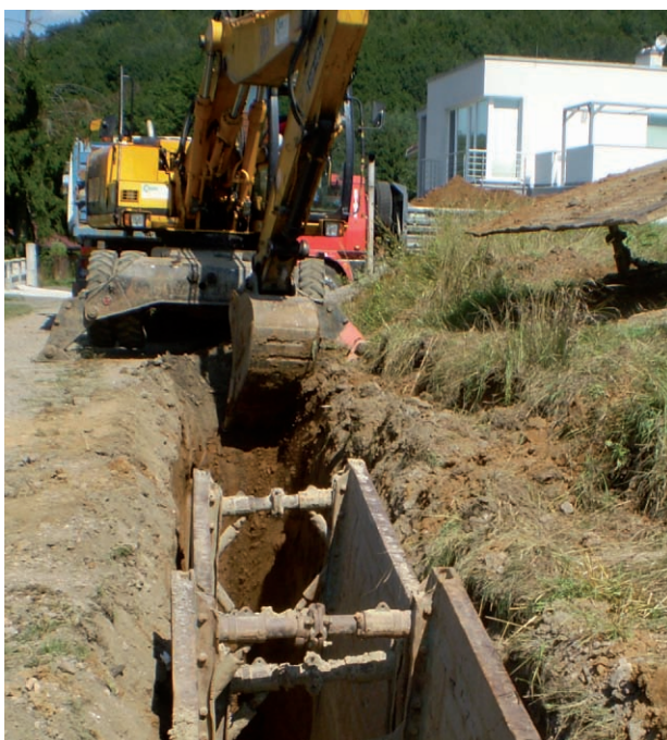
Budča - rozšírenie kanalizácie
