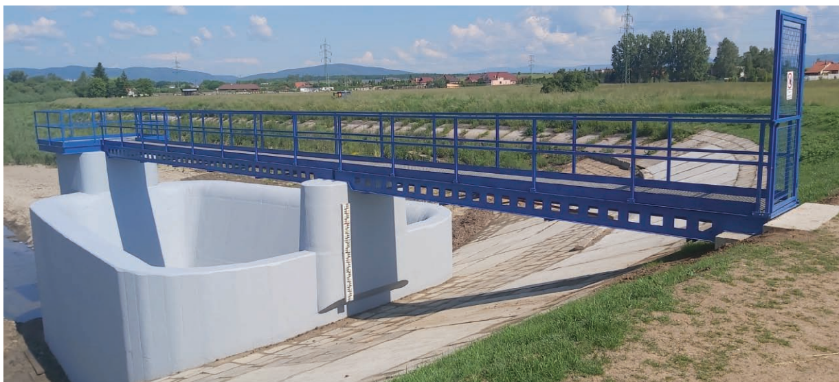
VD Ľadovo - rekonštrukcia bezpečnostného prepadu
