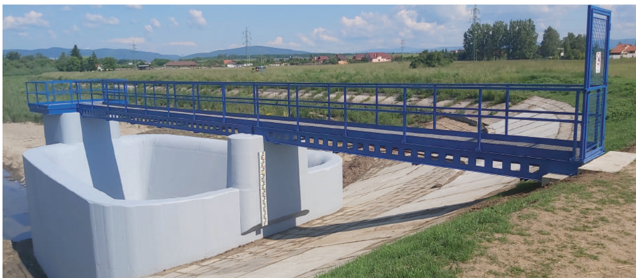
VD Ľadovo, rekonštrukcia bezpečnostného priepadu
