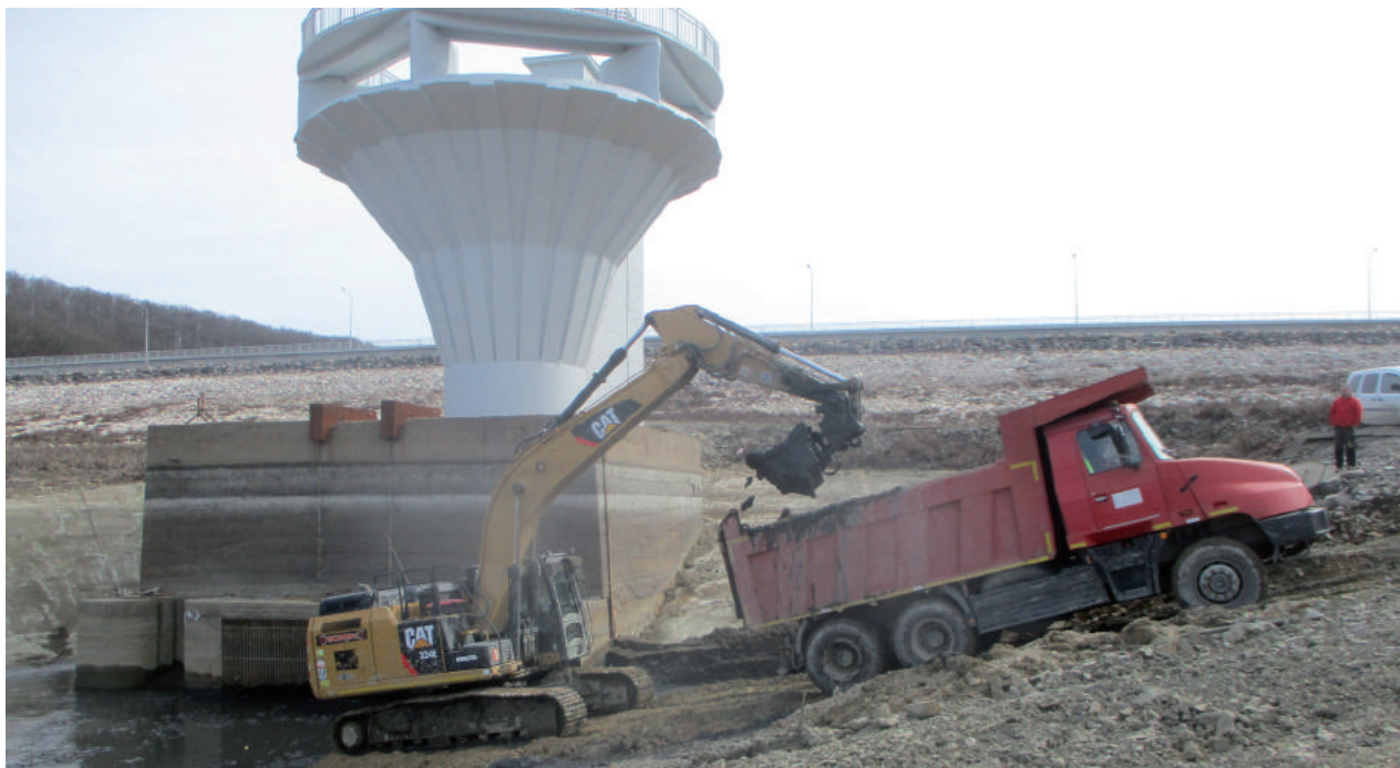
VS Ružiná, oprava objektov
