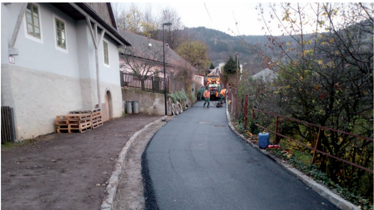
Banská Štiavnica - Dolná Resla - rekonštrukcia miestnej komunikácie
