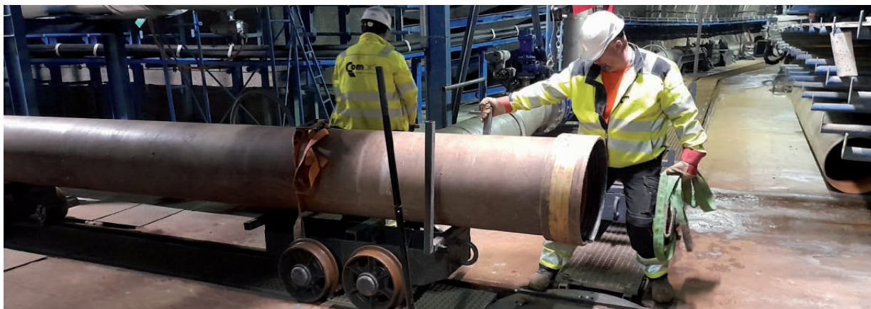
Brno, Kolektor - rekonštrukcia vodovodu
